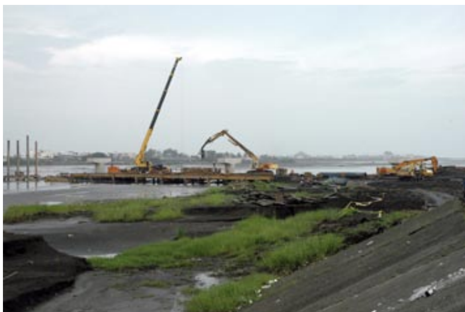
鐵路高架工程施工
